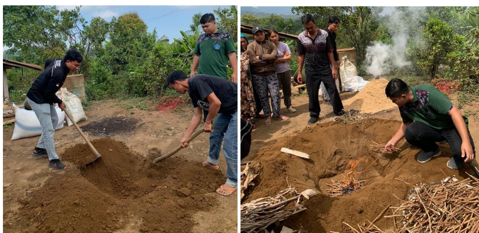
Gambar 7. Pembuatan lubang untuk pembuatan biochar mode kontiki
